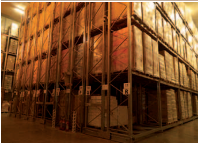
MAGAZZINO FREDDO (-25 °C) CON STRUTTURE COMPATTABILI.
