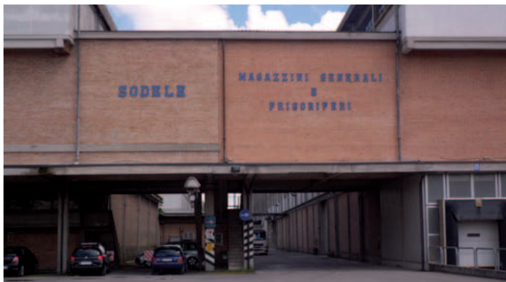
LA STRUTTURA ORIGINARIA DI SODELE. VIA VIA SULLA DESTRA SONO STATI REALIZZATI I NUOVI EDIFICI.
